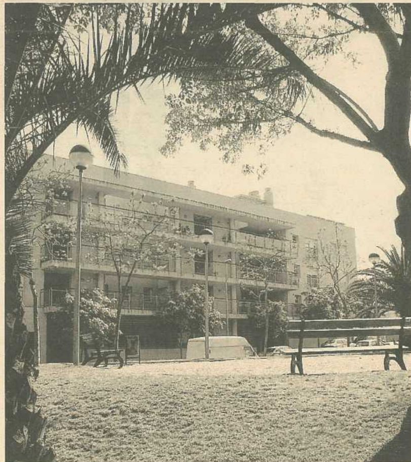
En la imagen, una promoción de viviendas protegidas en Mataró
