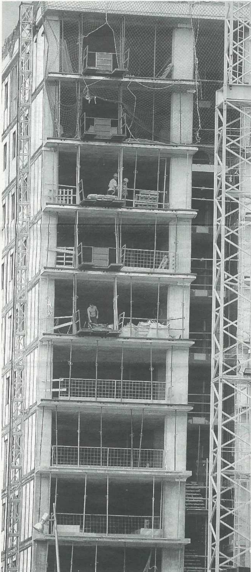
Viviendas en construcción. NEBRIDI ARÓZTEGUI
